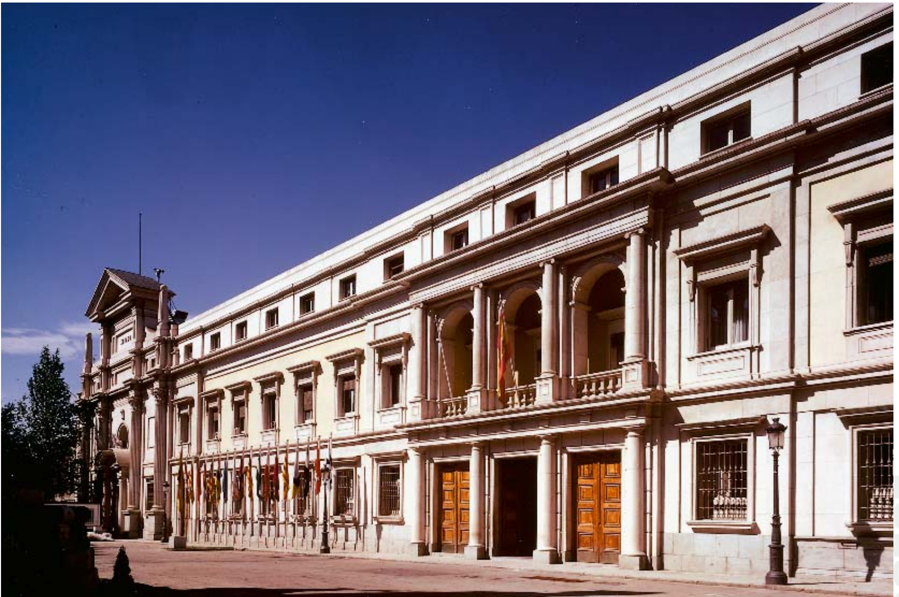
Edifici del Senat
